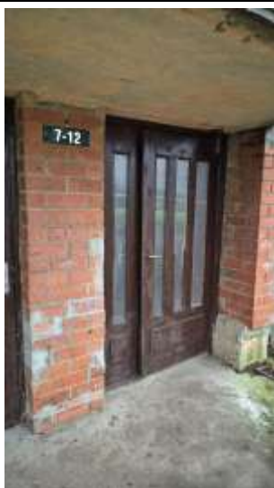
Kāpņu telpas ārdurvis
